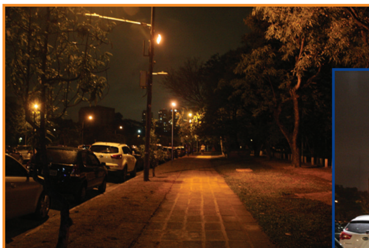
ANTES: trecho da avenida Luciano Gualberto com iluminação antiga
