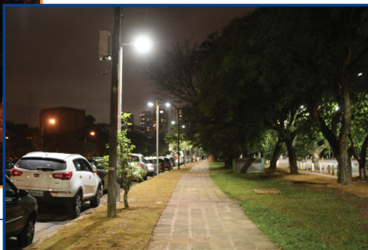
DEPOIS: mesmo trecho com o novo sistema de iluminação
